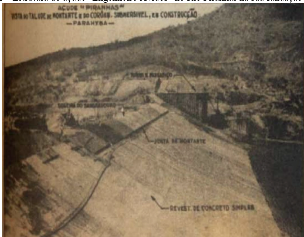
Foto 2 – Estrutura do açude “Engenheiro Avidos” no Rio Piranhas na sua fundação (1936)
